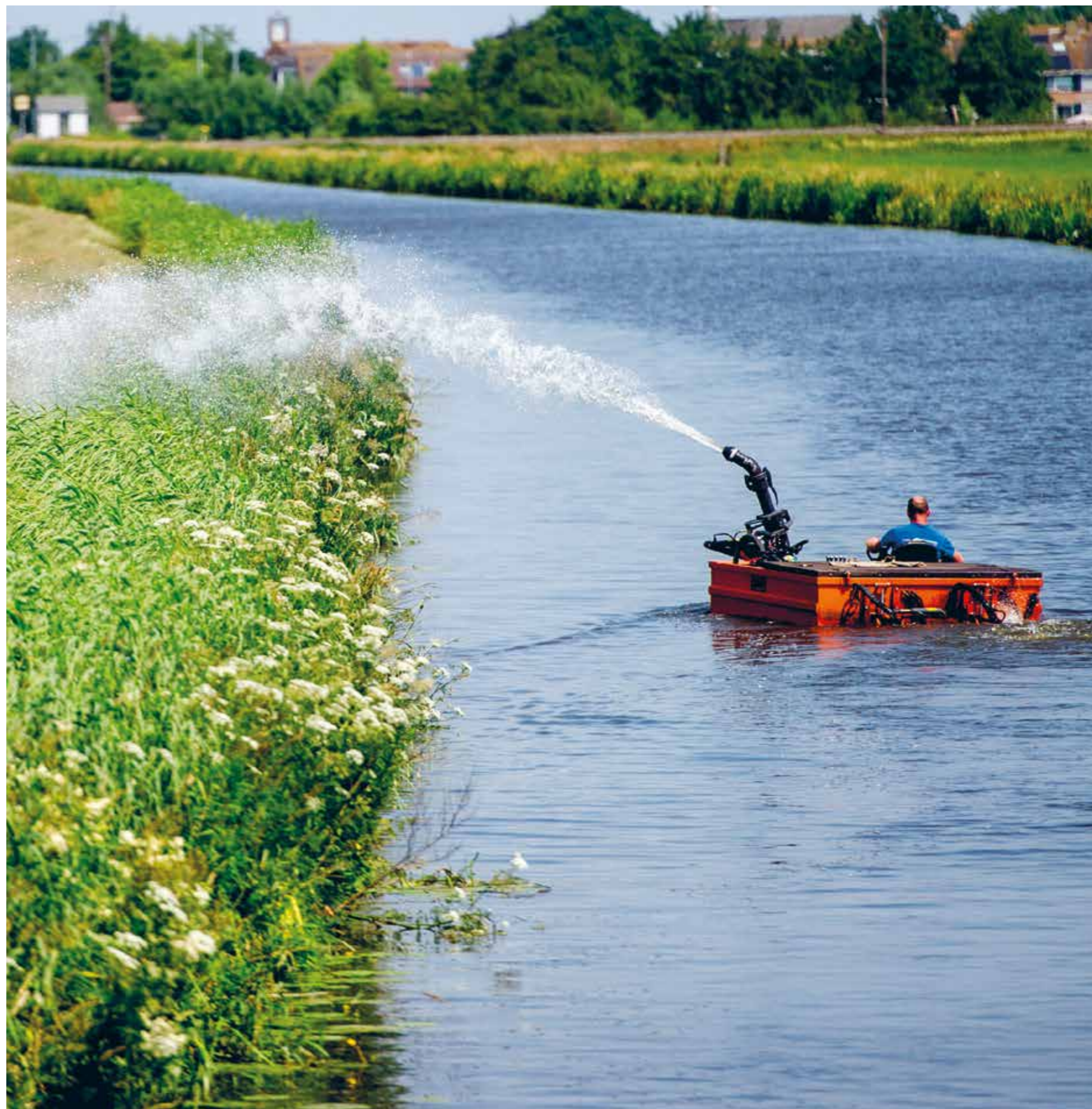
Bij Nieuwerbrug aan den Rijn worden tijdens periodes van hitte en droogte de dijken gespreid om scheuren te voorkomen. | Foto Robin Utrecht, ANP
