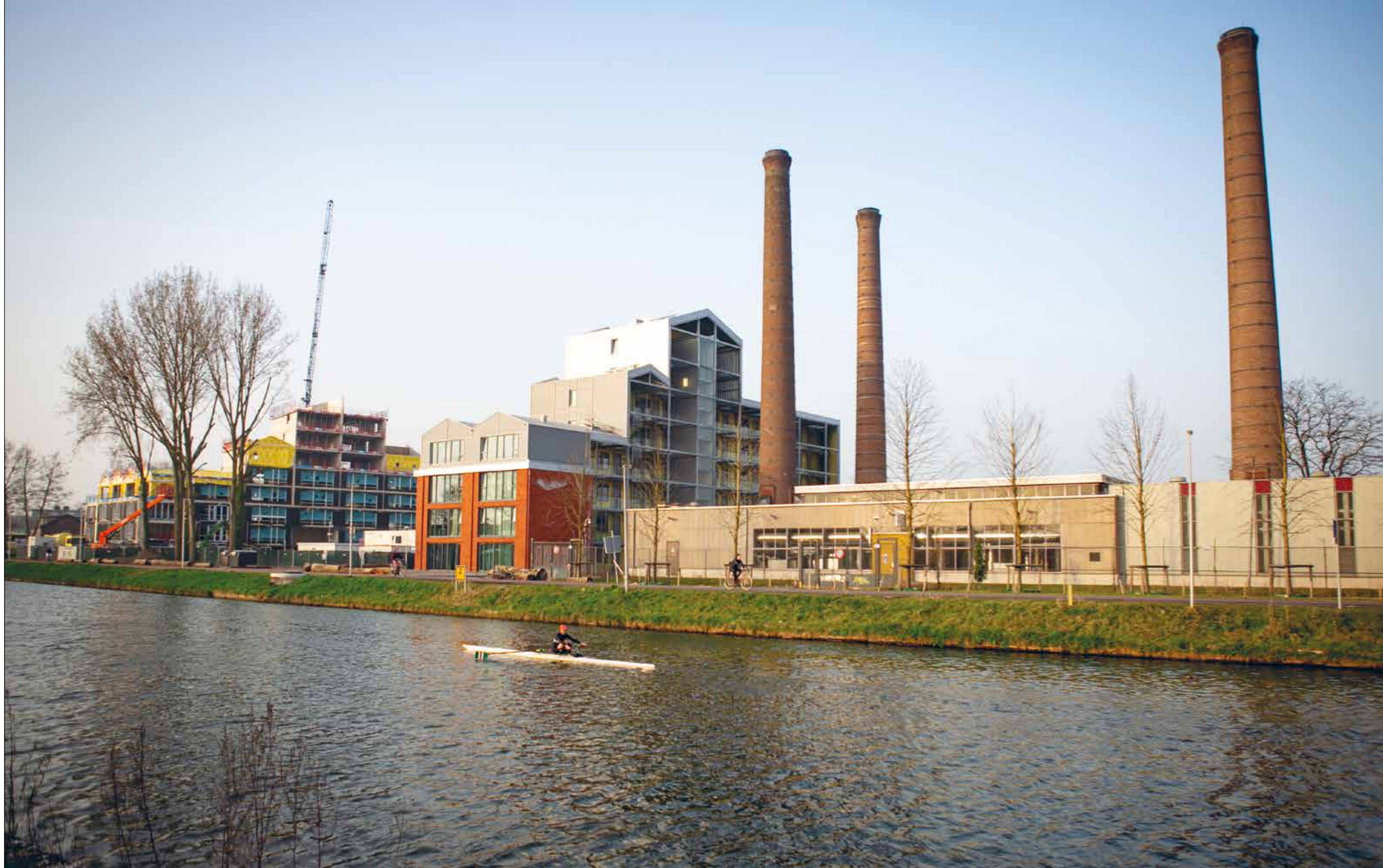
Grootschalige nieuwbouw in de Merwedekanaalzone in Utrecht. Dit is project Wilhelminawerf op het oude Eneco-terrein, een wooncomplex met binnenhaven naast drie monumentale schoorstenen. | Foto Tirzah Schnater
