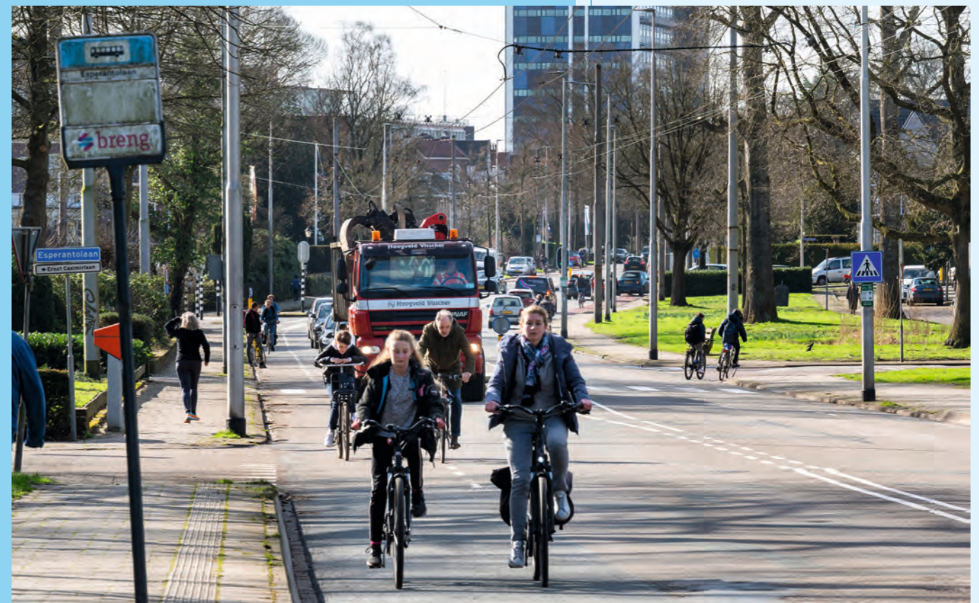
Fiets, auto en zwaarder verkeer maken nu nog allemaal gebruik van de brede asfaltbaan. | Foto Gerard Burgers
