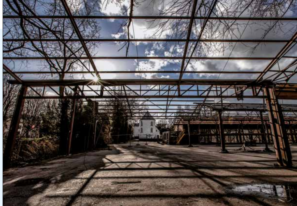
De ontmanteling van de voormalige houthandel Scheijmans in Weert was in februari 2020 in volle gang. | Foto Jeroen Kuit
