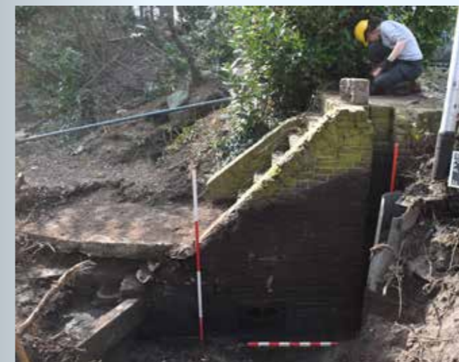
Resten van de Pothoofdsluis tijdens opgravingen in het voorjaar van 2021. | Foto Gemeente Deventer
