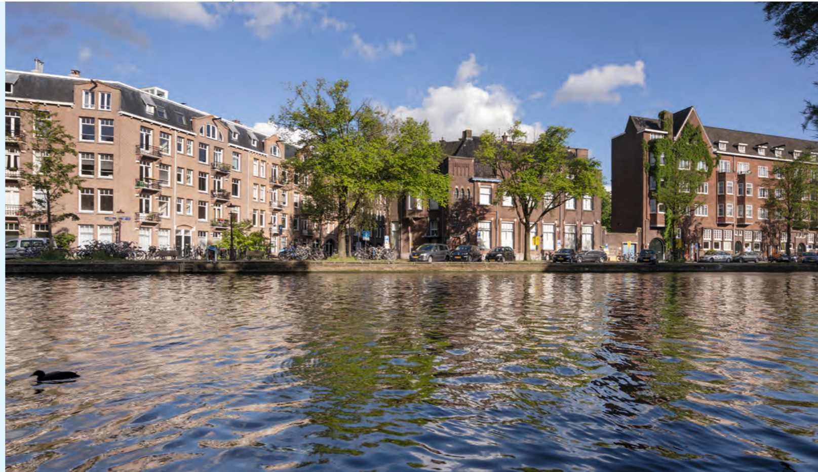
Het monumentale schoolgebouw aan de Kostverlorenkade uit 1914 (midden op de foto) wordt straks verwarmd met energie uit energiepalen en -damwanden. | Foto Els Zweerink
