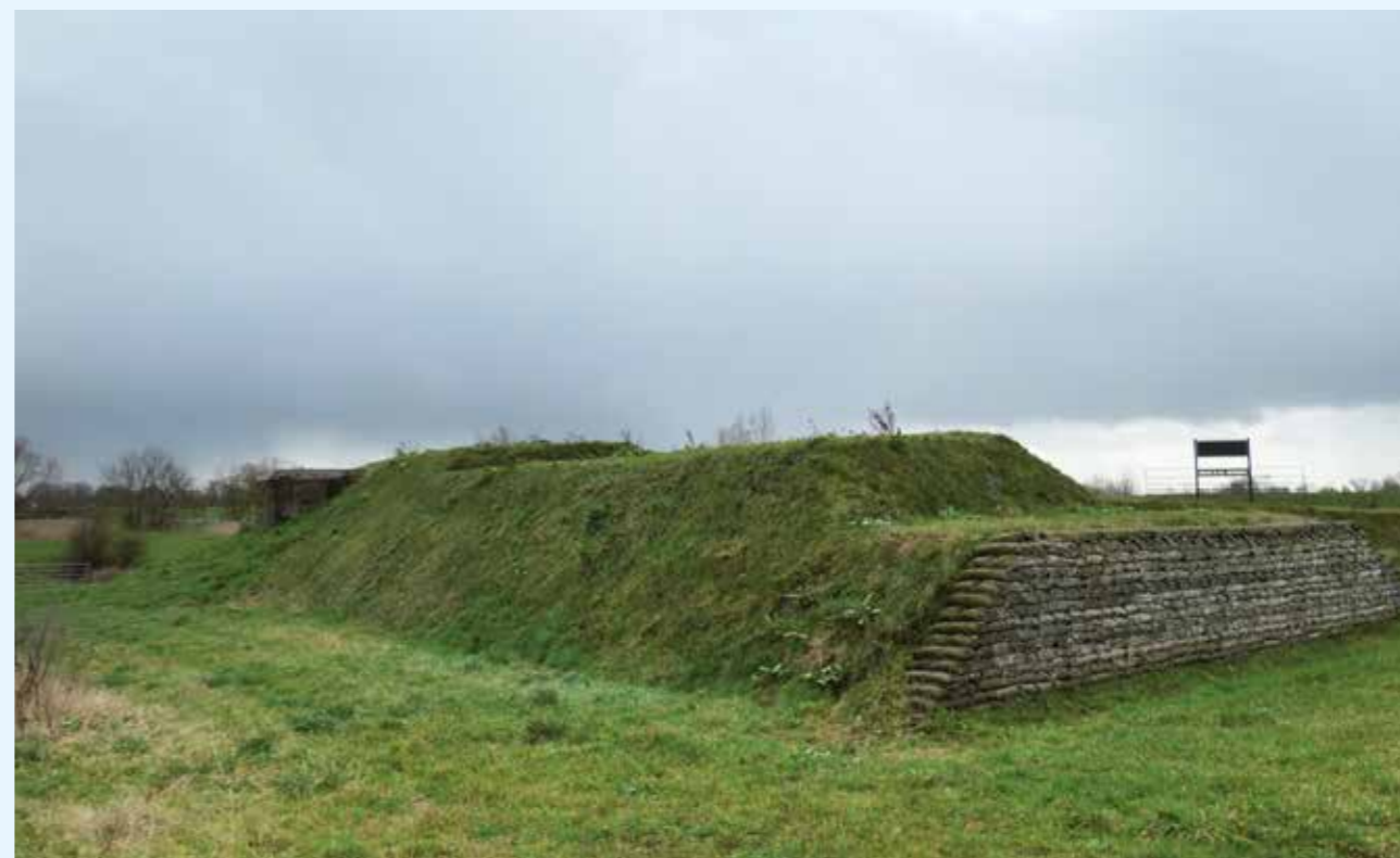
Dit deel van het Hoornwerk is al gerestaureerd. Langs de weg van Rhenen naar Wageningen is een coupure aangelegd, opgebouwd uit juten zakken gevuld met beton. | Foto Waterschap Vallei en Veluwe
