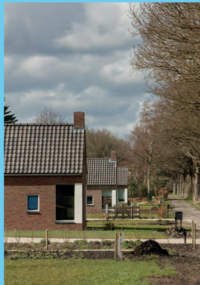
Ambtenarenhuisjes in Frederiksoord. | Foto Albert Brunsting
