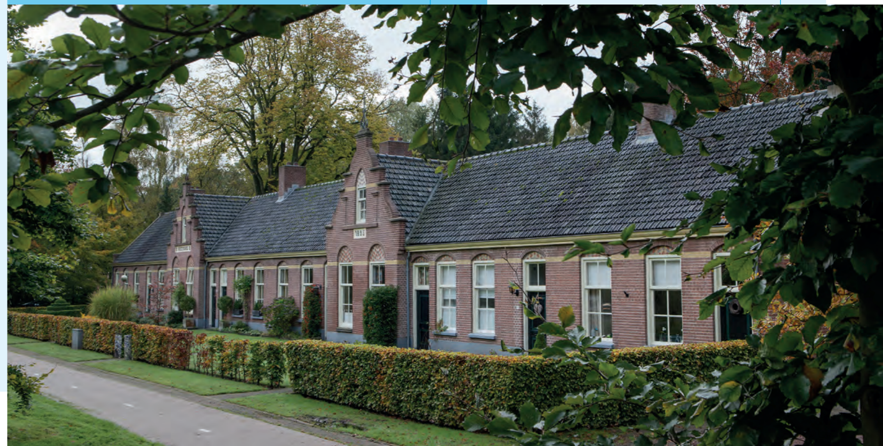
Rustoord I (1893) een voormalig bejaardentehuis in Wilhelminaoord van de Maatschappij van Weldadigheid. | Foto Albert Brunsting
